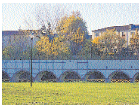
Sopra, scorcio dell'area a lavori conclusi. A destra, il ponte della Ceronda.
