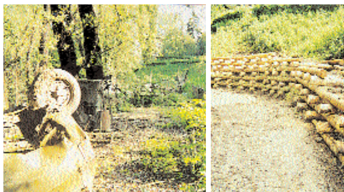
A sinistra, orti abusivi prima dei lavori. A destra, la palificata a doppia parete
