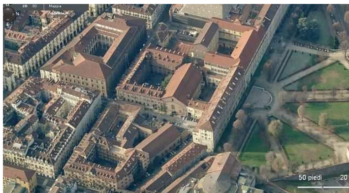
Una veduta aerea dell'area della Cavallerizza Reale
