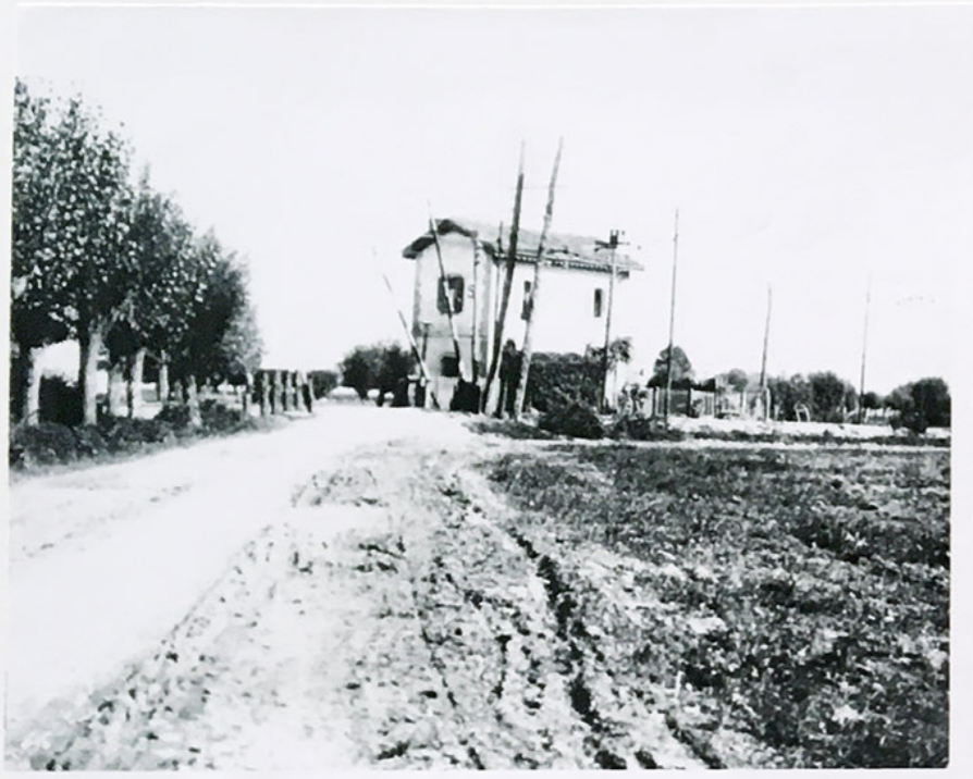
VIA TOLMINO - FERROVIA A RASO E CASELLO MANUALE
