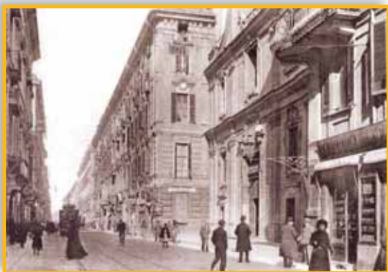
Via Garibaldi, l'antica Contrada di Doragrossa
