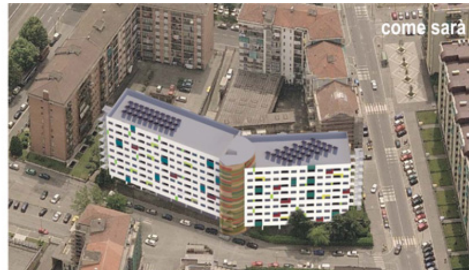
Veduta Facciata NORD
