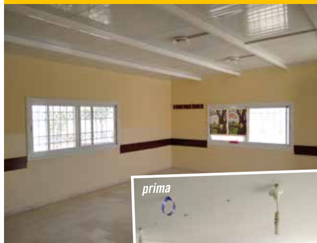
Scuola di Dkeika (area C): ristrutturazione di un'aula scolastica e sostituzione del soffitto
