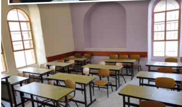
Scuola di Al Nahada: ristrutturazione di un'aula scolastica
