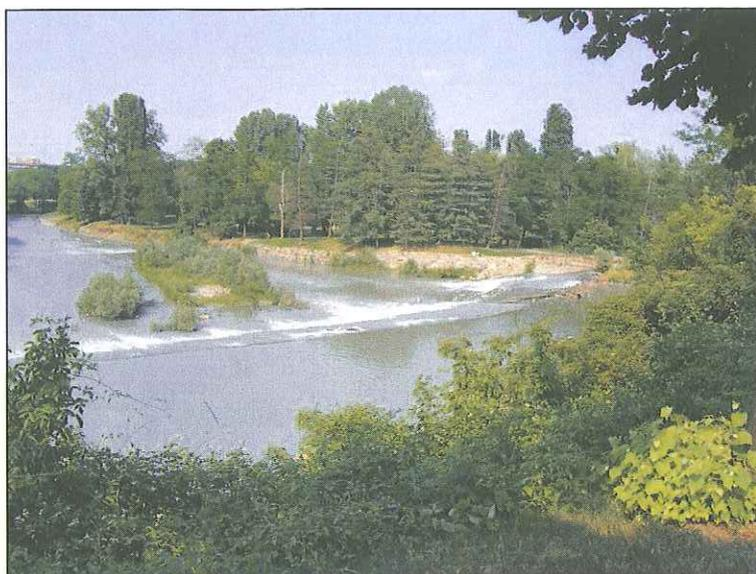
**Figura 2 - Traversa fluviale della Dora Riparia in corrispondenza dell'opera di presa del canale Pellerina.**
