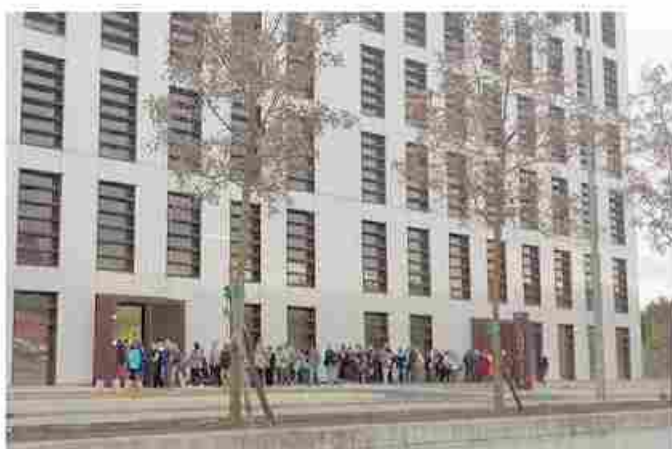
L'ingresso del Poliambulatorio nell'area Montefibre
