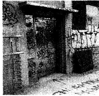
Gli ascensori rotti
