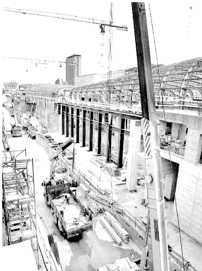
Il cantiere del passante ferroviario
