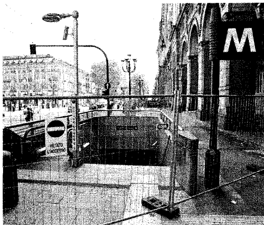
L'ingresso transennato della metro tra Porta Nuova e via Sacchi
