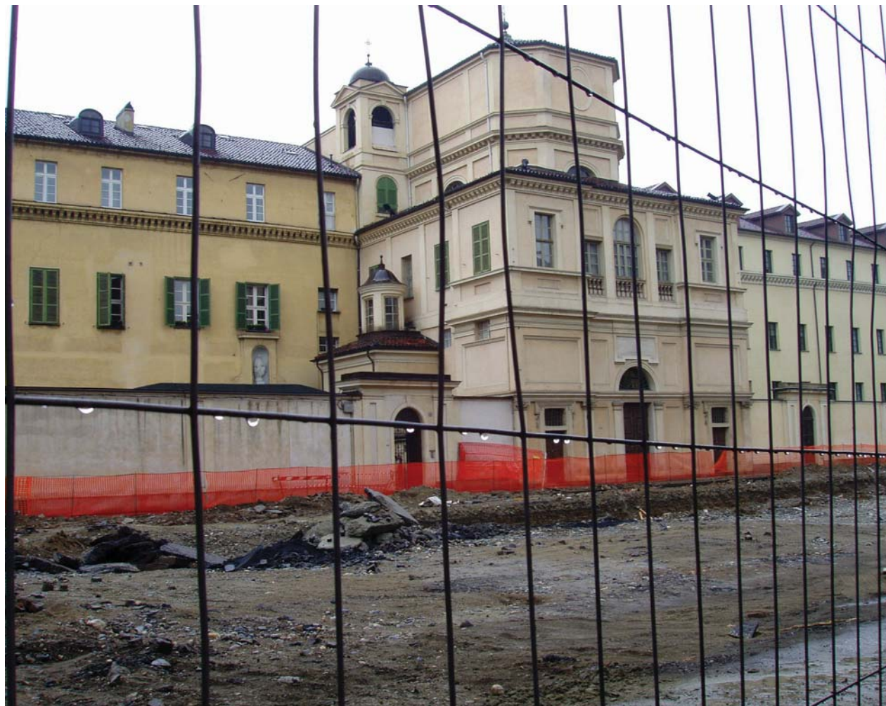
Il cantiere della metropolitana in largo Marconi.
