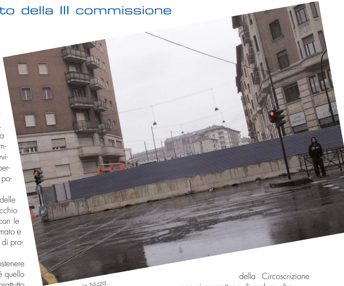
Il cantiere in via Nizza.
