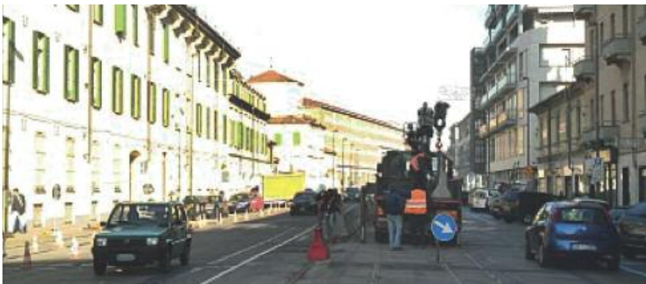
Via Nizza libera dai cantieri della Metropolitana
