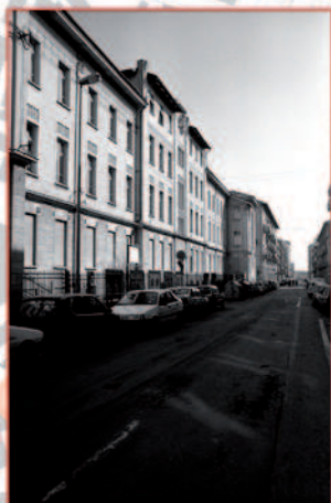
Scuola Gabelli, facciata su via Santhià
