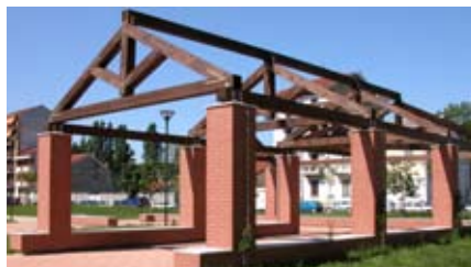
Pergolato con pilastri in mattoni e capriate in legno (foto B. Musso-4 a Circoscrizione 2005)
