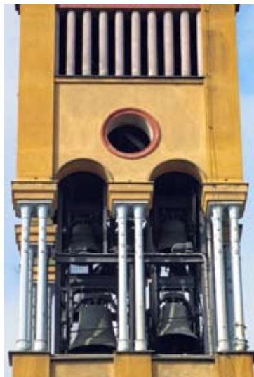
La cella per il concerto campanario; circondata da 32 colonne di ghisa, è situata a metà circa del campanile; la campana del "Fa" (Faà...) fu pagata dalla famiglia del Beato (archivio 4 a Circoscrizione 2009)
