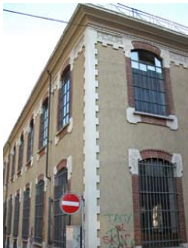
Stabilimento ex-conceria Fiorio, facciata all'angolo tra via Durandi e via Vidua (archivio 4ª Circoscrizione 2009)
