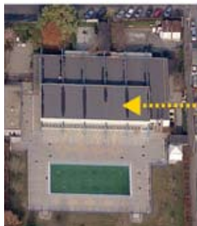
Torino, Piscina Franzoj a tetto aperto (in alto, versione estiva con il pubblico sul prato) e a tetto chiuso (in basso); da notare la struttura portante a vista (ripresa satellitare, elaborazione da MS Live Search Maps)
