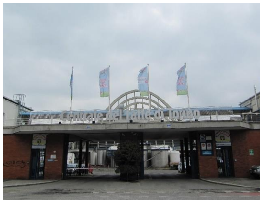
La centrale del latte di Torino, 2017
