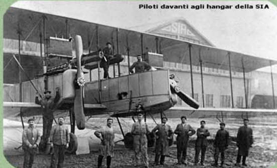
Piloti davanti agli hangar della STA
