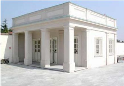
Sono stati effettuati interventi di consolidamento strutturale, di risanamento e di formazione di elementi di completamento quali le nuove pavimentazioni, i serramenti in legno e le coperture in strutture lignee con lastre di tamponamento in lose di pietra.
