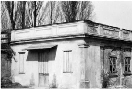
I due bassi fabbricati, di impianto ottocentesco, sono stati liberati dai tamponamenti e le mancanze sono state integrate con tecnologie attuali ma congruenti con l'architettura delle fabbriche. Il crollo completo delle volte e delle coperture ha richiesto, infatti, interventi di restauro e reintegrazioni delle parti mancanti molto rilevanti.
