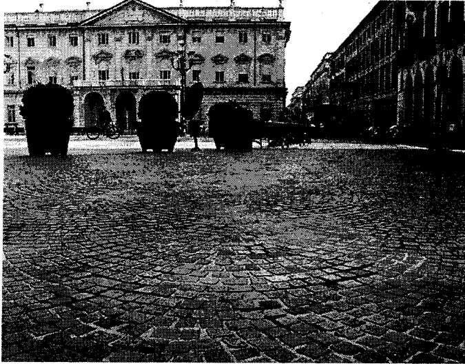
Ecco come si presenta la pavimentazione di piazza Bodoni
