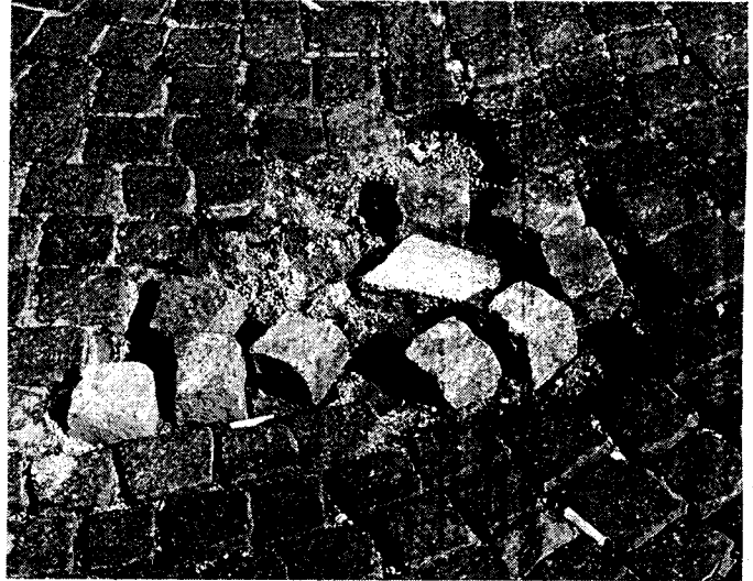
Un dettaglio dello stato in cui versano i cubetti di porfido
