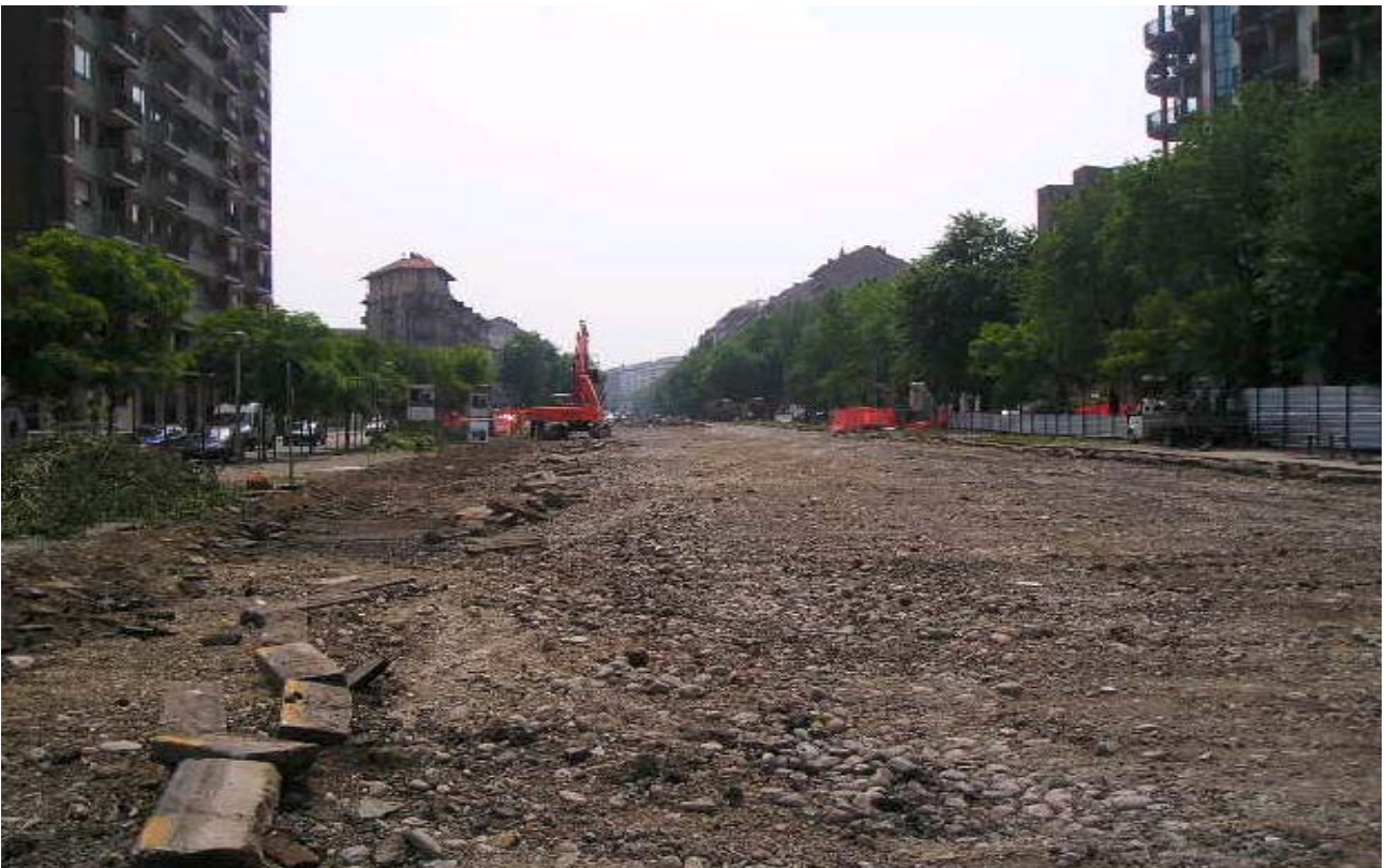
Foto 113-114 : prescavo superficiale in c.so Trapani
