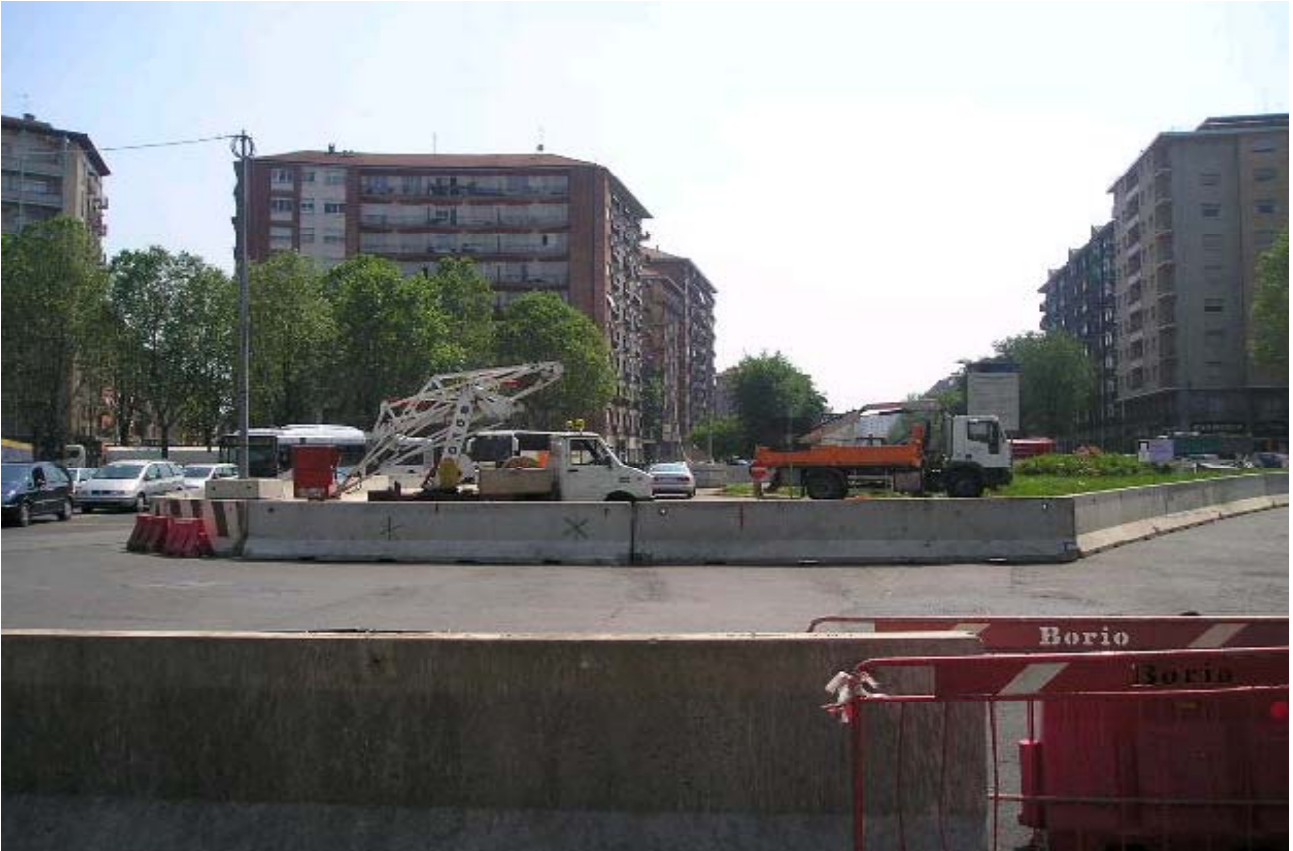
Foto 95-96 : delimitazione area di cantiere su piazza Rivoli
