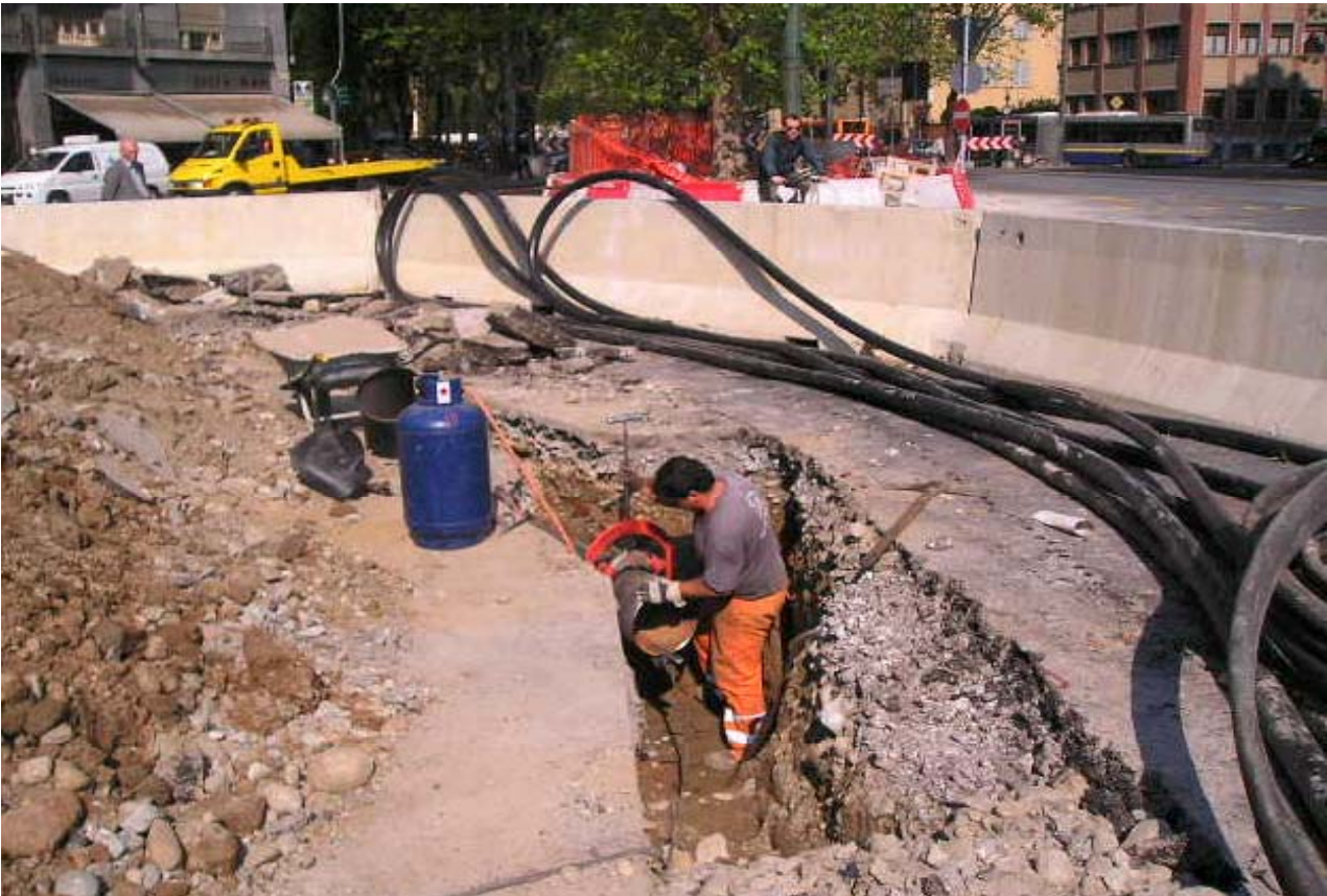
Foto 117-118 : spostamento tubazioni rete AES
