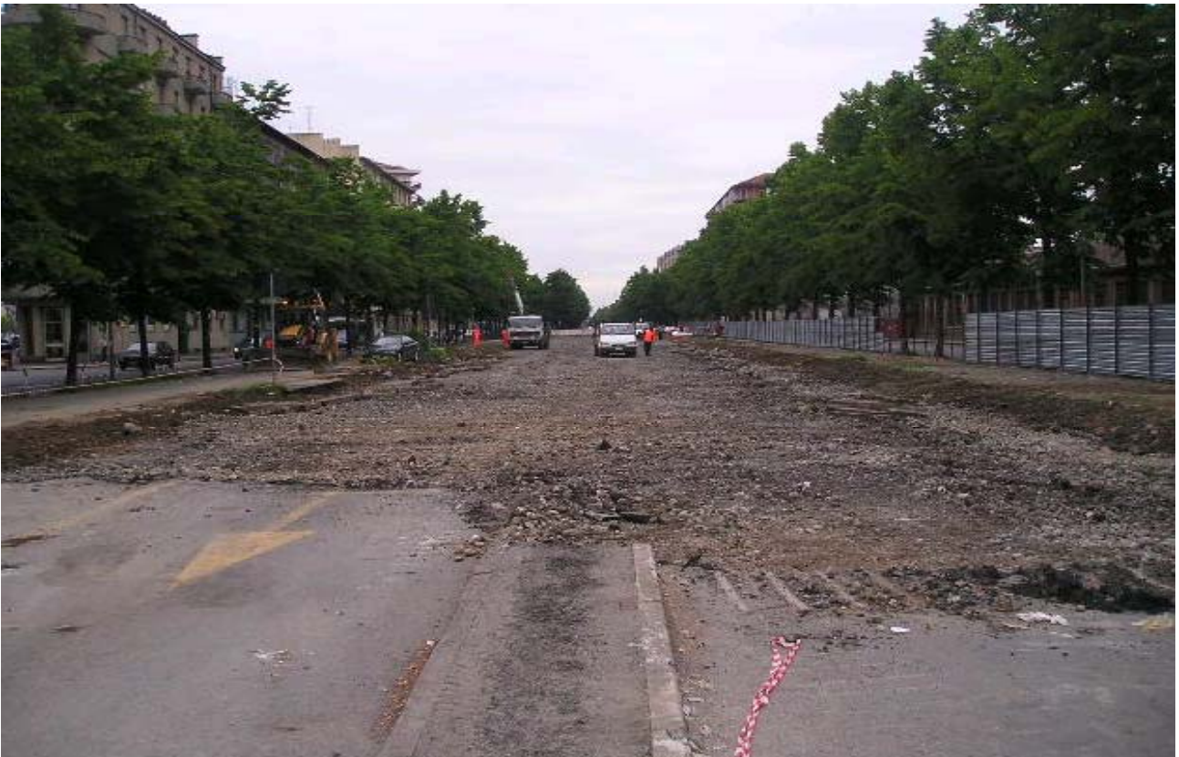
Foto 111-112 : prescavo superficiale in c.so Lecce
