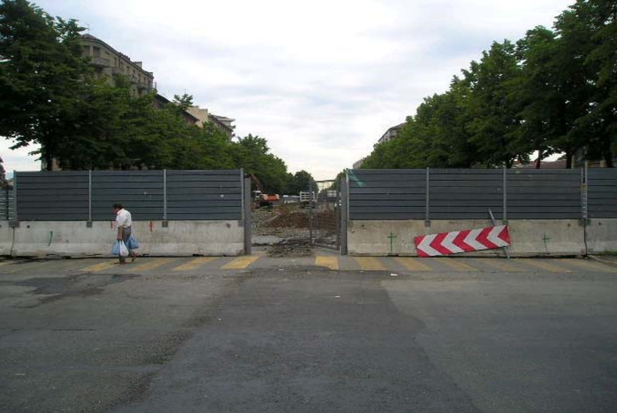
Foto 99-100 : delimitazione area di cantiere su corso Lecce
