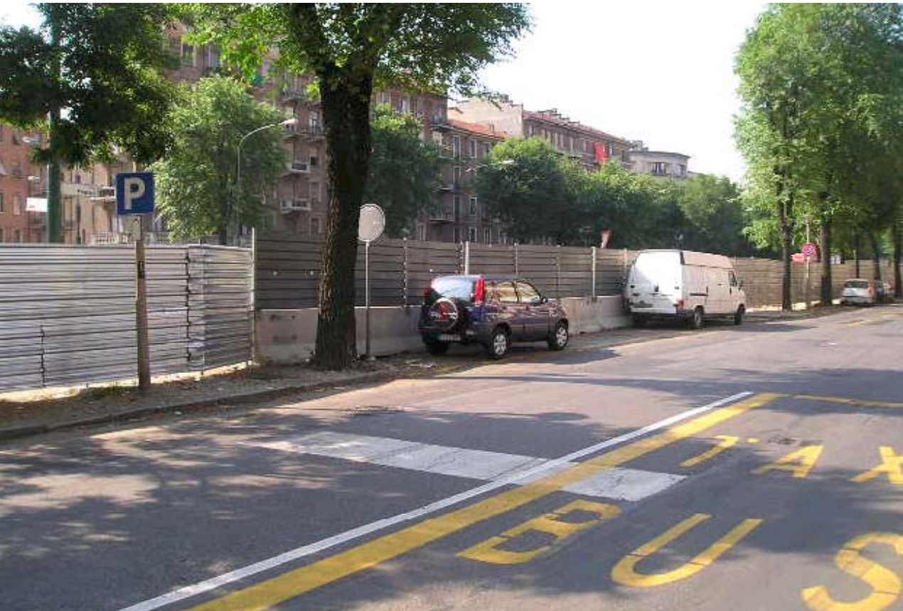
Foto 105-106 : tracciamento segnaletica orizzontale per nuove aree di sosta sul controviale di c.so Trapani
