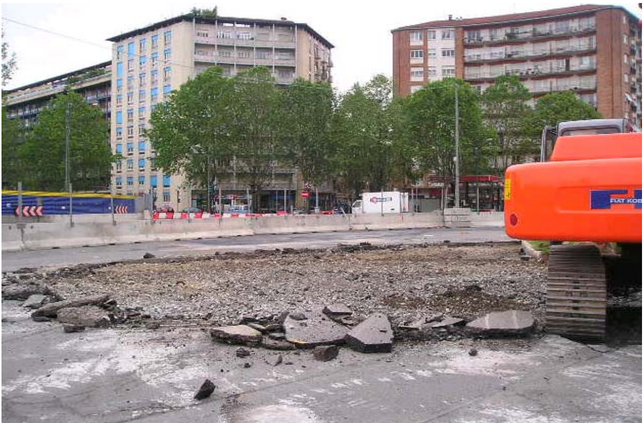
Foto 115-116 : prescavo superficiale in piazza Rivoli
