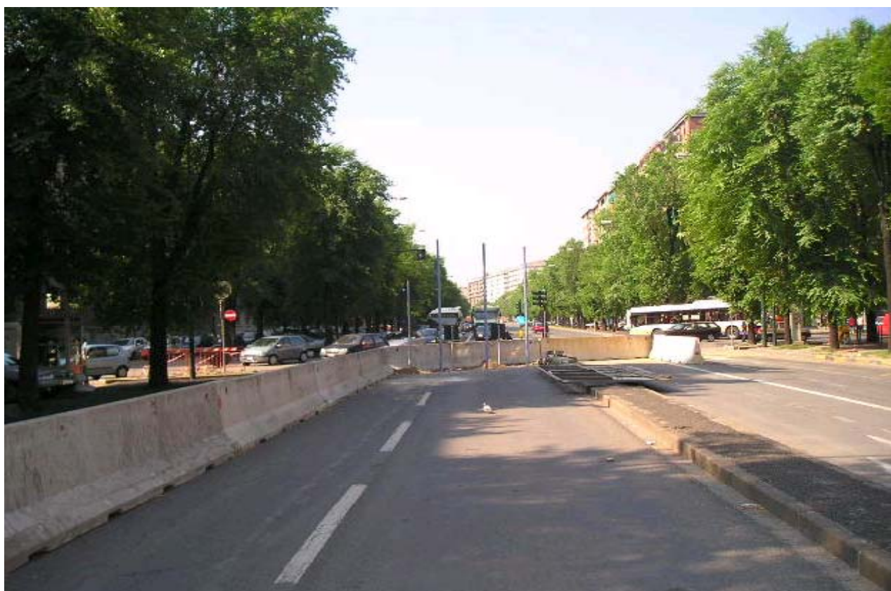
Foto 97-98 : delimitazione area di cantiere su corso Trapani
