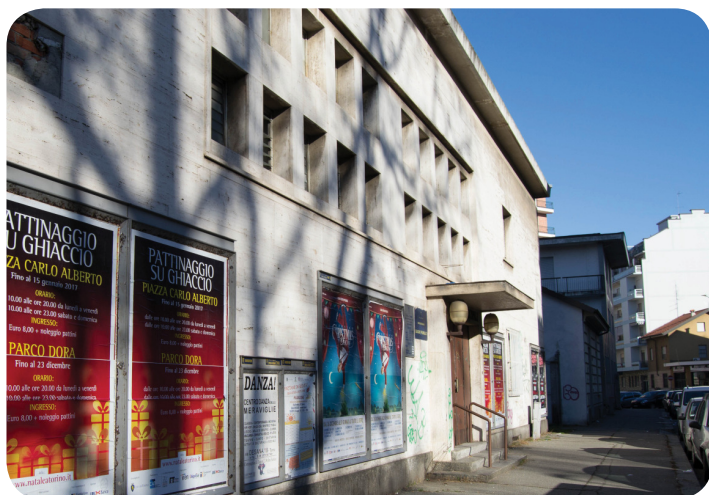
VISTA DELL'EDIFICIO DA VIA CONTE DI ROCCAVIONE
