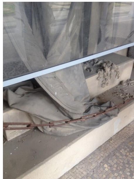
Degradati superficiali del materiale lapideo
