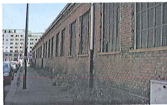
EDIFICIO ABBANDONATO IN VIA BAGNASCO
