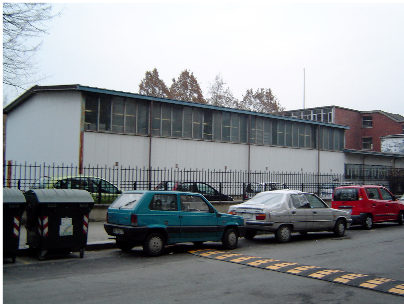
Foto 3 Prospetto Est (palestra)
