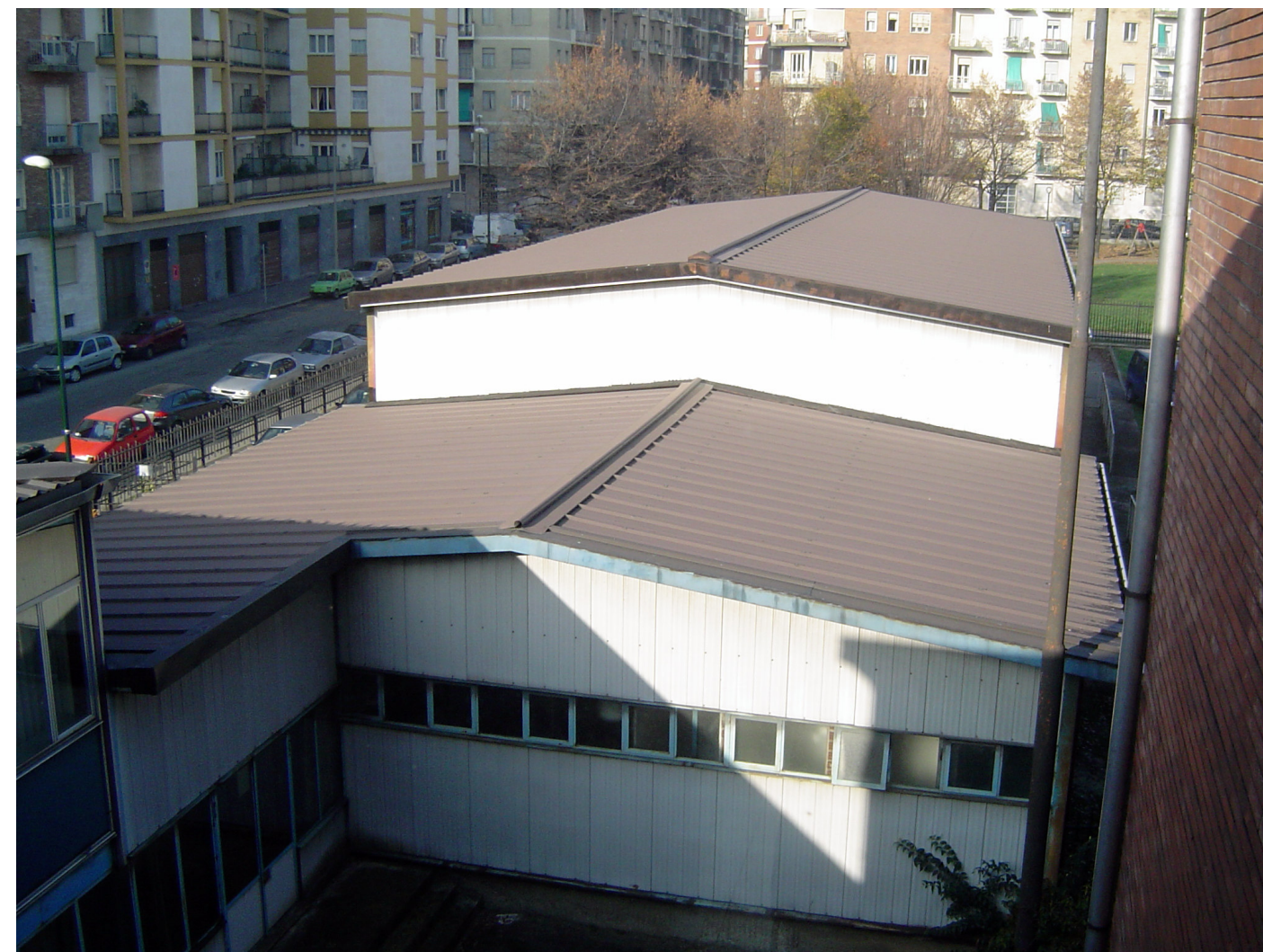
Foto 10 Veduta Palestra verso Via Malta
