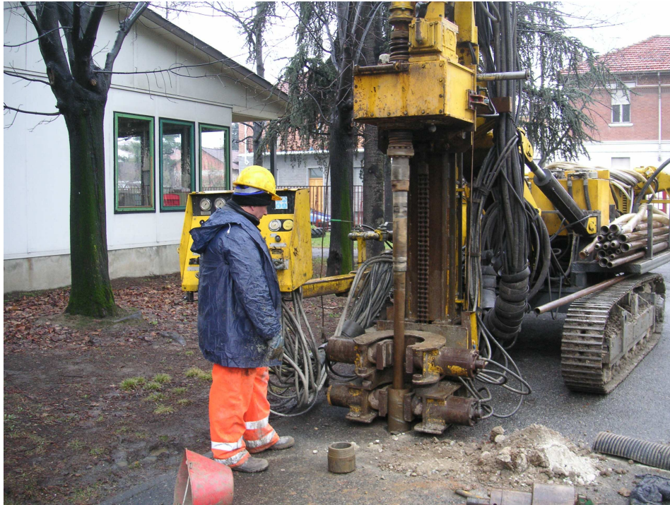
Foto 1: Sonda in fase di carotaggio
