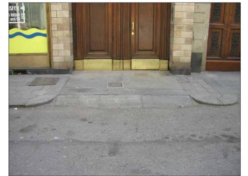
Durante il rifacimento della rampa occorrerà predisporre delle griglie carrabili per permettere l'uscita degli automezzi
