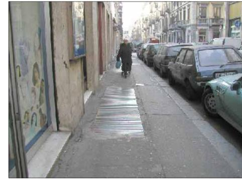
Durante il rifacimento del marciapiede l'impresa dovrà provvedere a mettere in sicurezza gli accessi pedonali ai negozi attraverso l'uso obbligatorio di passerelle metalliche con mancorrente
