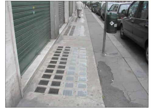
Durante il rifacimento del marciapiede l'impresa dovrà provvedere a mettere in sicurezza le griglie di areazione e il lucernaio del piano cantinato. Particolare attenzione dovrà essere posta durante le rimozioni del bitume a ridosso del piano in cls
