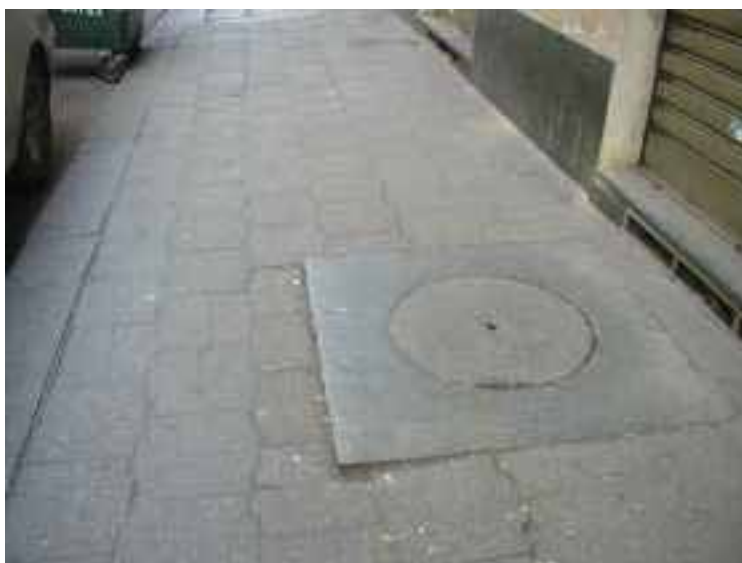
Un marciapiede di via Principe Tommaso con rivestimenti in marmette
