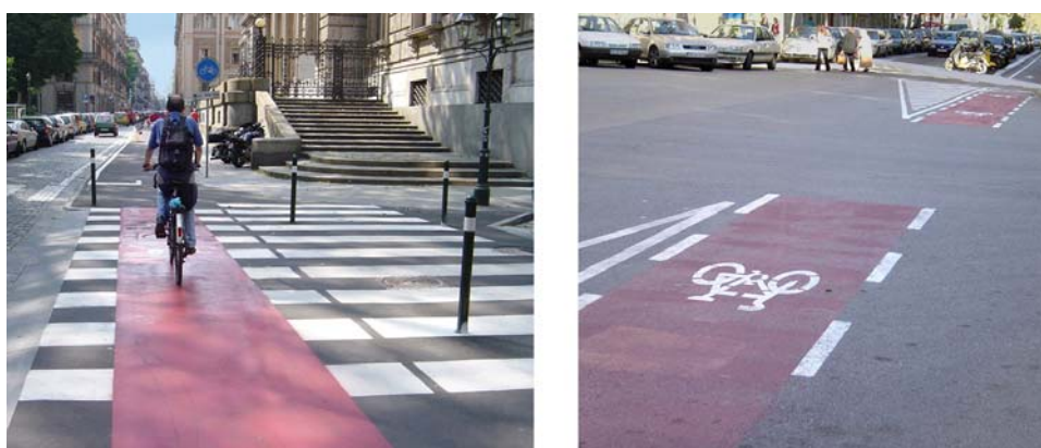
Figura 6 - La pista ciclabile dovrebbe essere sempre prolungata come corsia sull'intersezione, evitando le discontinuità (come nell'esempio di destra)
