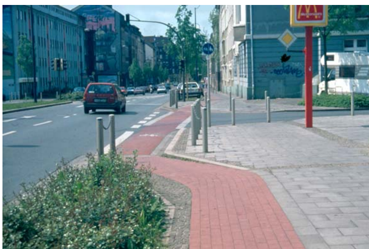
Figura 8 - Esempio di intersezione in cui la pista ciclabile viene avvicinata il più possibile alle corsie veicolari, per aumentare la sicurezza (fonte: sito Internet http://www.walkinginfo.org )
