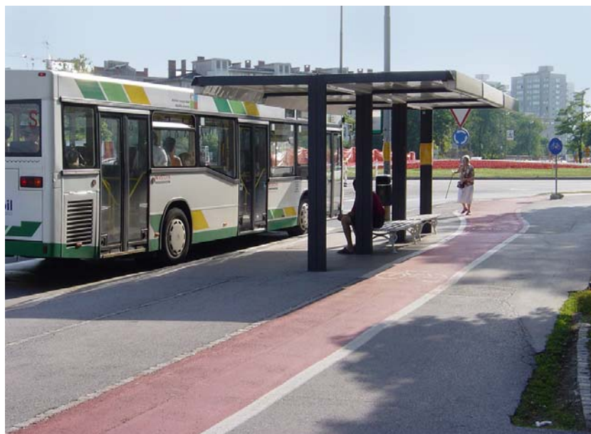
Figura 9 - In corrispondenza delle fermate dei mezzi pubblici, l'arretramento della corsia ciclabile è la soluzione più sicura per pedoni e ciclisti
