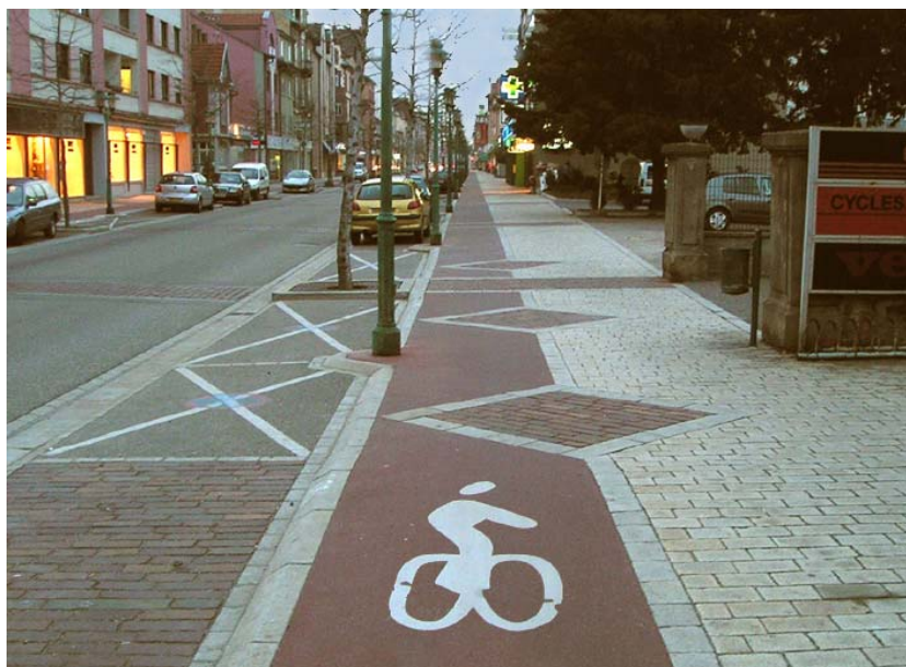
Figura 3 - Una pista ciclabile su corsia riservata, ricavata su un ampio marciapiede. La differente colorazione e tessitura della pavimentazione rende evidente la destinazione degli spazi; gli inserti quadrangolari sul marciapiede segnalano la presenza dei passi carrai
