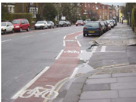
Figura 2 - Due piste ciclabili con corsia riservata ricavata sulla carreggiata, a fianco delle corsie veicolari
