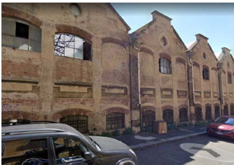
Vista della facciata "Fenoglio" da conservare
