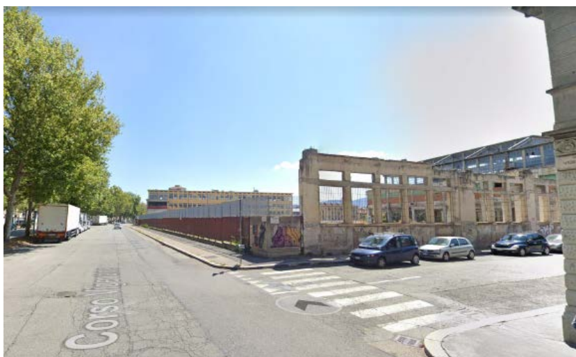
Vista dell'angolo tra corso Vigevano e via Damiano
